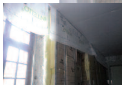
Adaptation d'une salle de bains et isolation thermique
