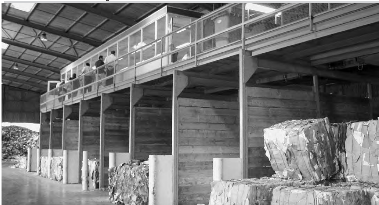
Centre de tri de déchets ménagers
