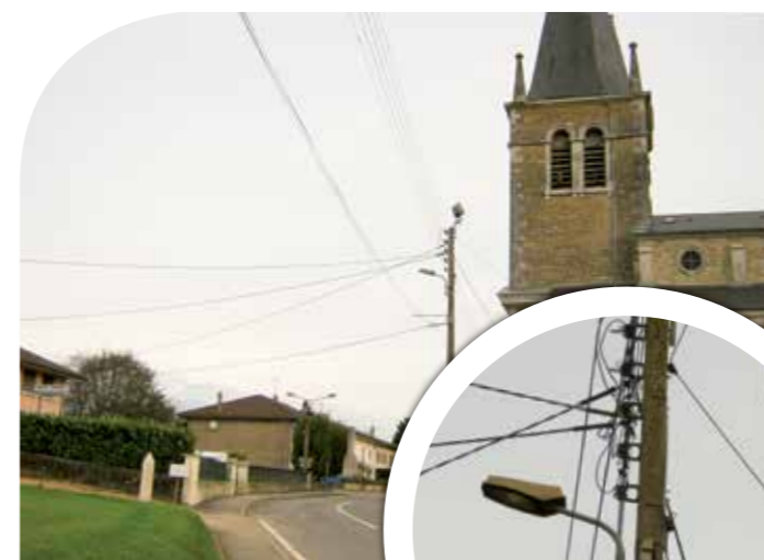
Eclairage public avant
