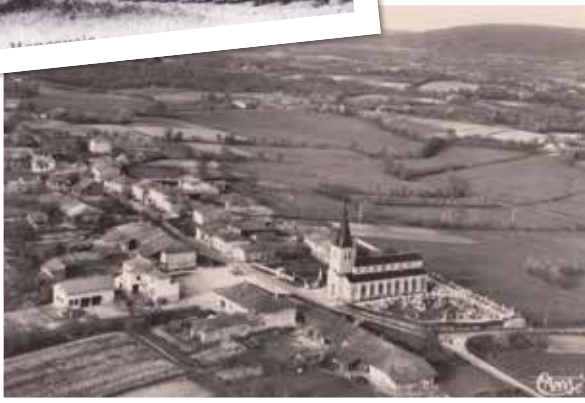
Vue avion entrée sud
