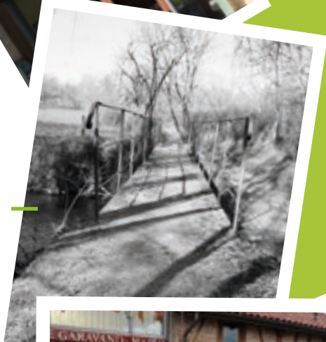
LA PASSERELLE DES GRILLETS
