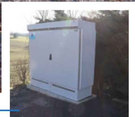
ARMOIRE DE LA FIBRE OPTIQUE
