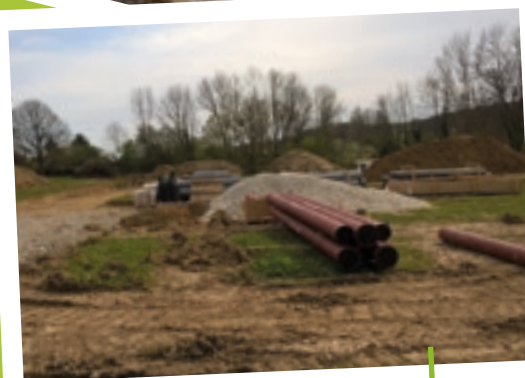
DÉBUT DE TRAVAUX AU LOTISSEMENT LE PETIT GRILLET
