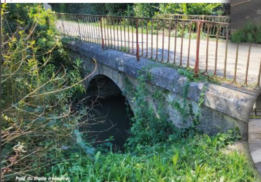
Pont du stade à rénover
