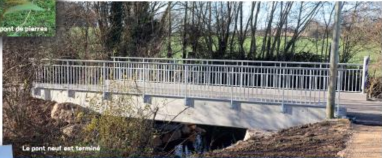
Le pont neuf est terminé
