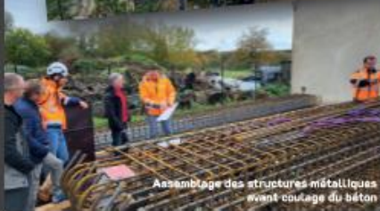
Coulage du béton dans les culées
